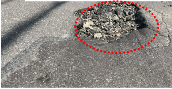
事例① 舗装損傷の穴ぼこによってタイヤのホイールが破損
