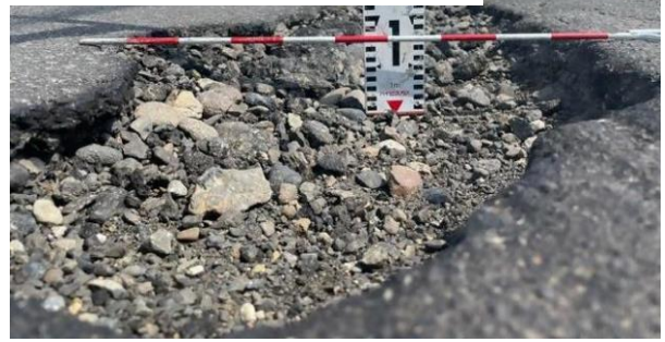
事例① 舗装損傷の穴ぼこによってタイヤのホイールが破損
