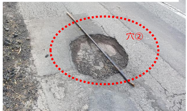
事例② 舗装損傷の穴ぼこが複数発生したことによってタイヤのホイールが破損
